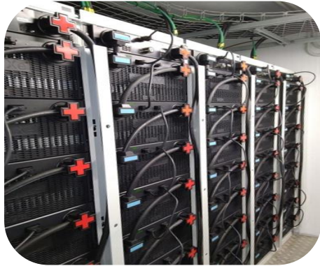
Tata Power DDL Lithium Ion
